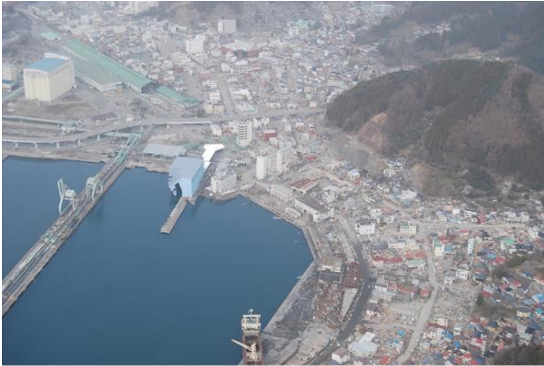
被災直後 平成 23 (2011) 年 3 月
