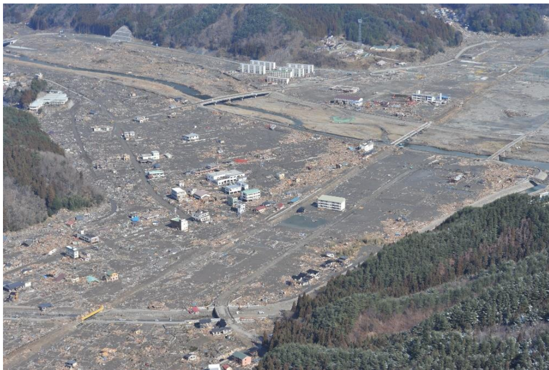
被災直後 平成 23 (2011) 年3月
