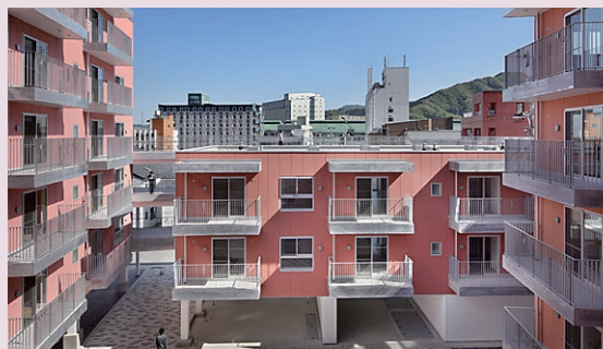
大町復興公営住宅1号（大町）
