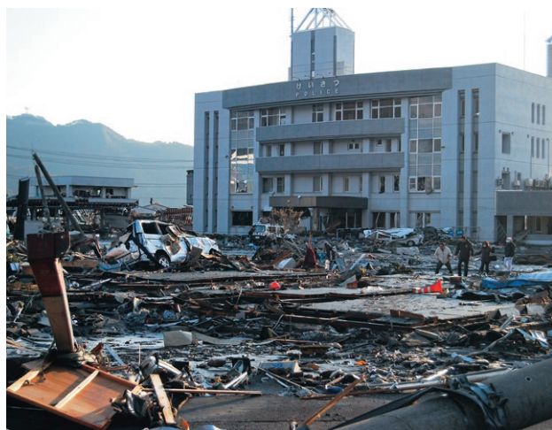
被災した釜石警察署（嬉石町）
