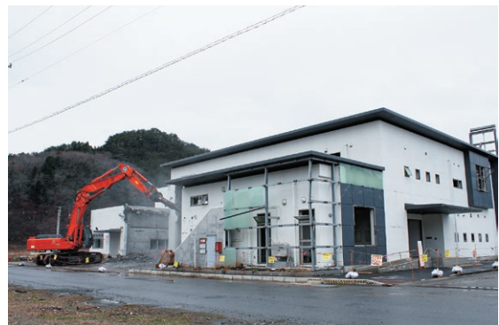
鵜住居地区防災センターの解体（平成25（2013）年12月）
