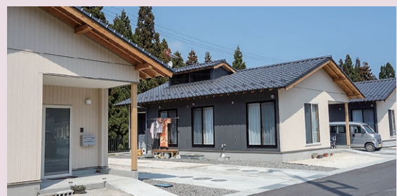
箱崎白浜復興公営住宅（箱崎町）
