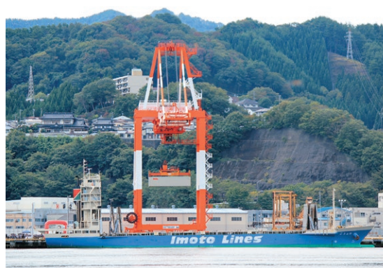
供用開始したガントリークレーン （平成29（2017）年9月）
