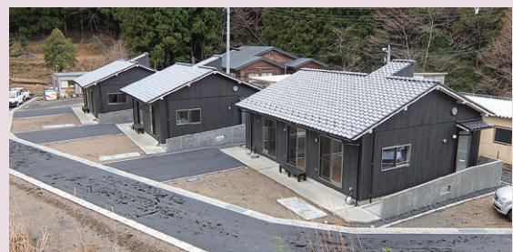
大石復興公営住宅（唐丹町）
