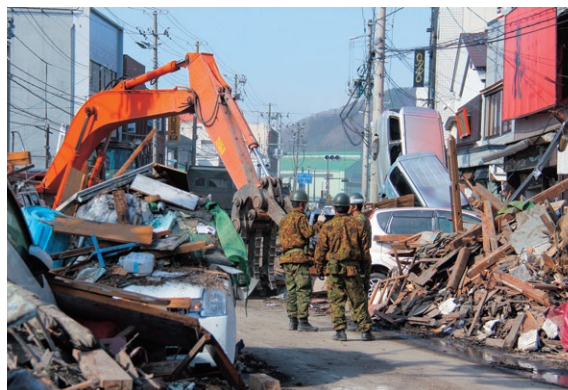
自衛隊による道路啓開作業（大渡町）
