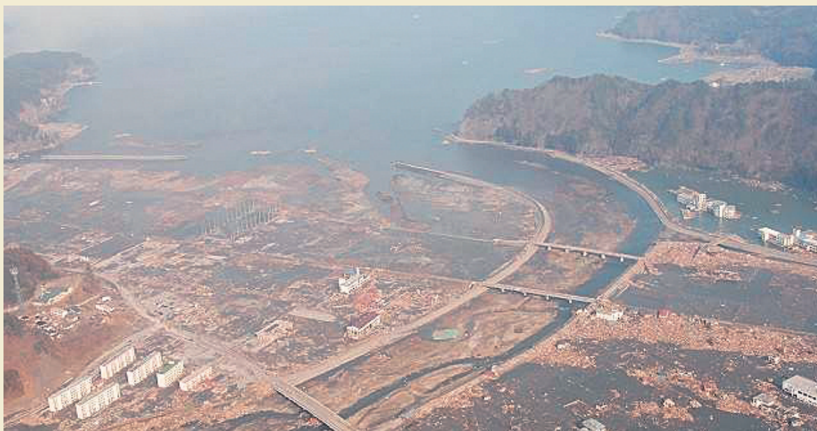
地震と津波により被害を受けた鵜住居・片岸地区
