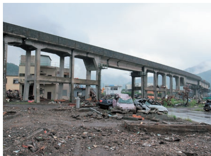
松原町（三陸鉄道高架橋下）
