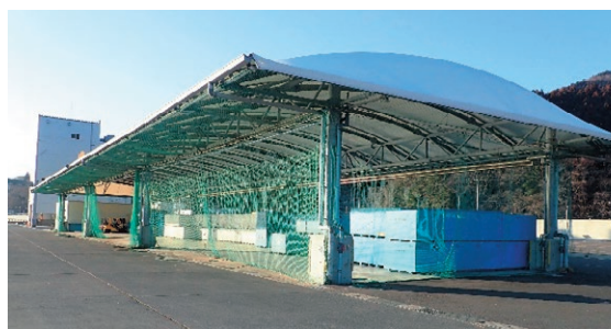
地方卸売市場釜石市魚市場新浜町売場 平成25（2013）年4月供用開始
