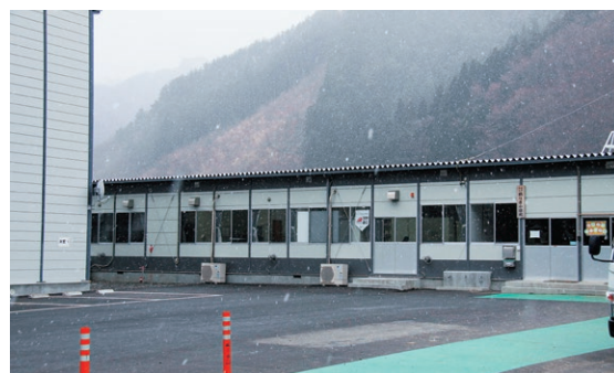
鵜住居小学校仮設校舎
