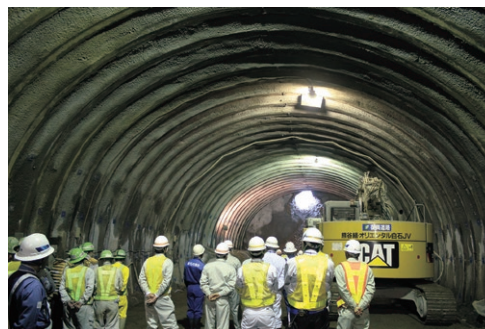
三陸道トンネル貫通 (平成25(2013)年10月24日)
