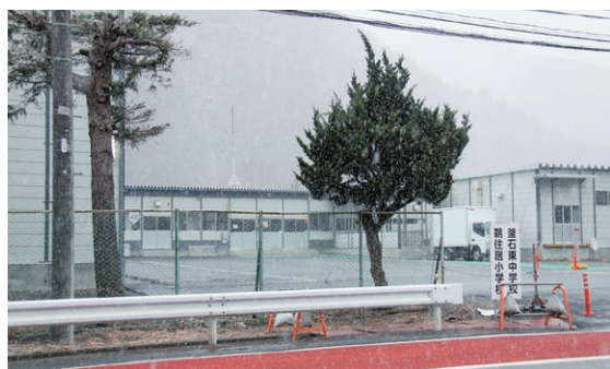
鵜住居小学校・釜石東中学校仮設校舎
