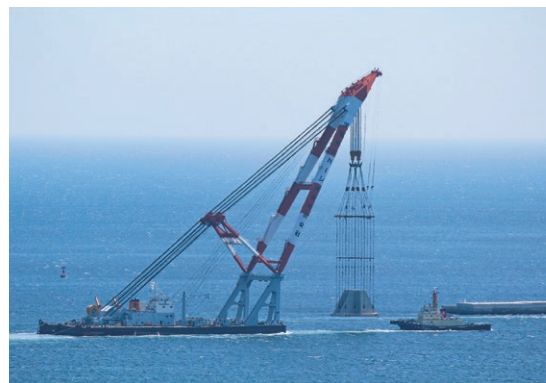
釜石港湾口防波堤工事の様子 (平成27（2015）年5月)
