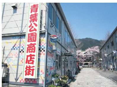
仮設による青葉公園商店街 (大只越公園)
